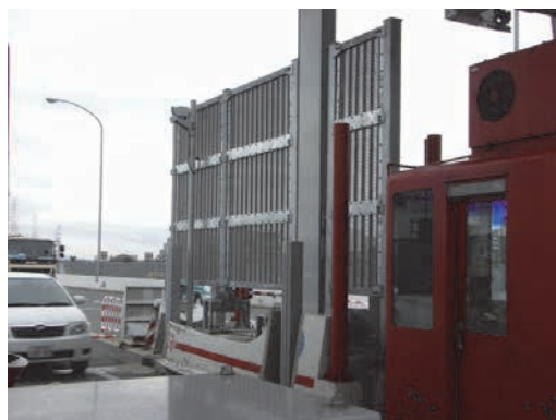
格子型電波吸収体(ETCに対応)
